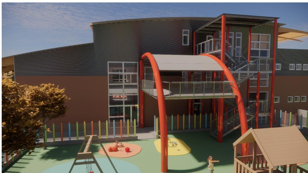
La struttura è realizzata mediante profili tubolari metallici 193.7 x 10, al fine di riprendere la stessa geometria ed architettura degli elementi già presenti. I cosciali sono costituiti da profili UPN240, le travi di piano e di copertura, rispettivamente, da IPE180 e HEA160.
