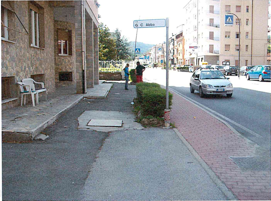
7 Via Trento Trieste-Via Abba LAT: 44°22'02,90" LONG: 8°12'12,03" - Interrato
